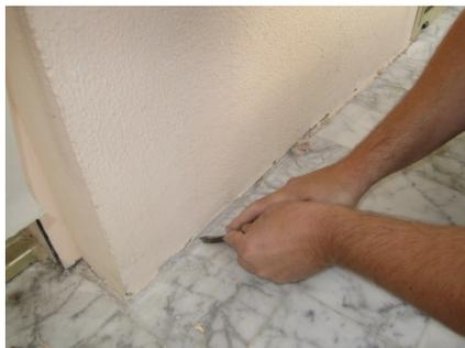
Enlever les joints avec un cutter tant sur le marbre que sur le mur, aspirer soigneusement les poussières
