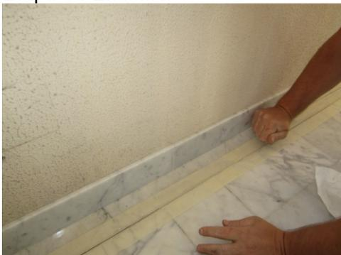
Encoller les plinthes avec la même colle en prenant soin de poser des forts points sur l'arrière de la plinthe, un filet sur le bord inférieur et de chaque côté. Coller la plinthe sur le mur par tapotement manuel. Faire le joint supérieur voir photo ci-dessus.
