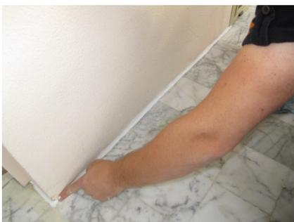
Déposer le joint Master MS Pro avec la cartouche et le pistolet, suivre les consignes ci-dessus.
